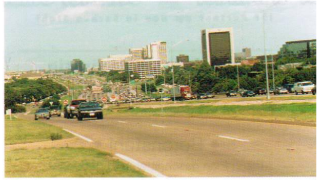
Auf dem Highway Richtung Dallas
